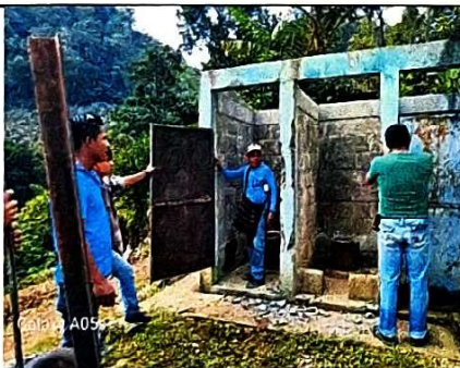
Foto 5. Desinstalando la puerta del servicio sanitario
