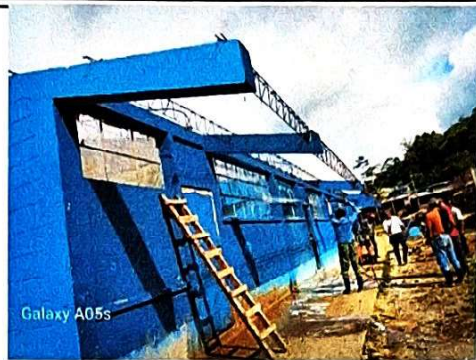
Foto 2: mantenimiento de los hierros y paredes exteriores de la escuela
