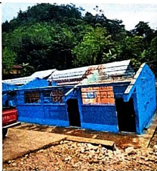
foto 3. Pintando los hierros en estructura de la base de la lamina
