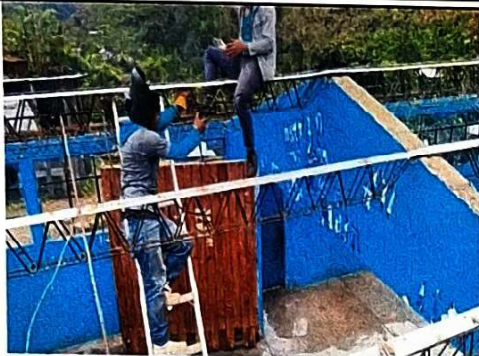
Foto1: Colocacion de costanera galvanizada para cubierta de lamina
